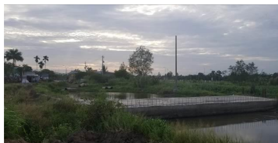
Dự án Cầu đường số 1
